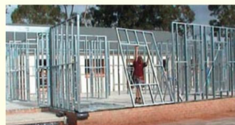
3. FIJACIÓN FINAL A LOSA
